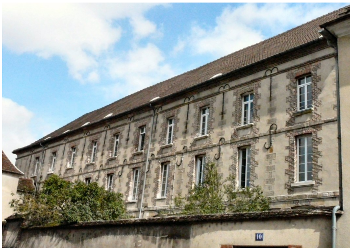
Le grand bâtiment construit par les Ursulines de Sens (rue Victor-Guichard). (photo Daniel Bulot)
