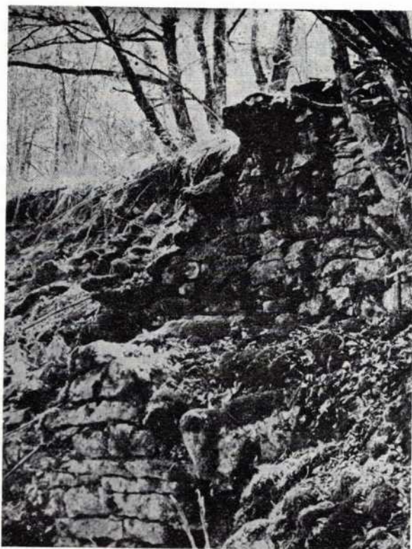
Fig. 2. — Le mur B (cliché S.F.A.Y.)
